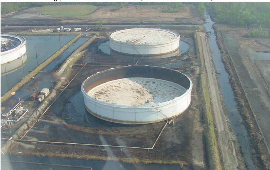
Figuur 9. Verschoven atmosferische opslagtank en ander stormvloedschade als gevolg van een orkaan, inclusief verschoven leiding (Bron: NOAA Office of Response and Restoration)
