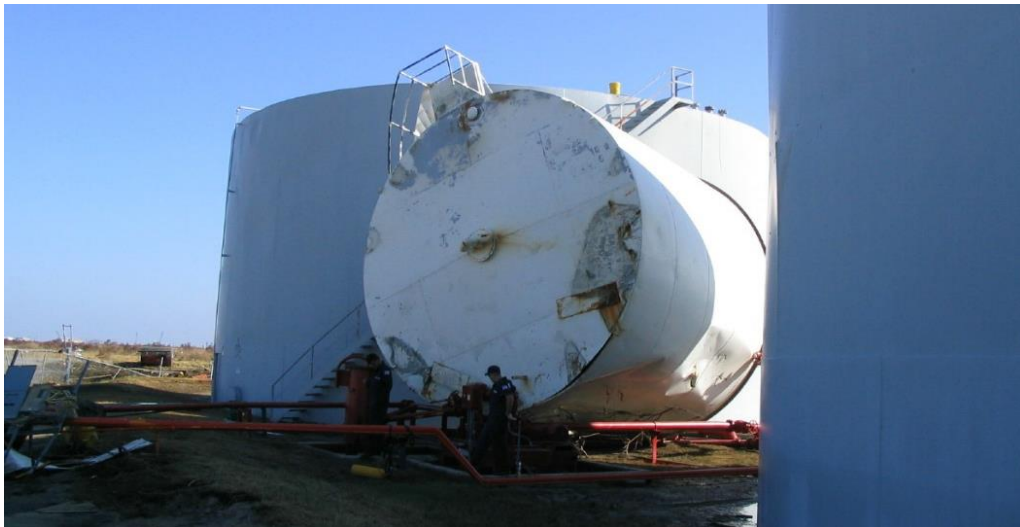
Figuur 10. Omgevallen en beschadigde atmosferische opslagvat vanwege een stormvloed na een orkaan (Bron: NOAA Office of Response and Restoration)
