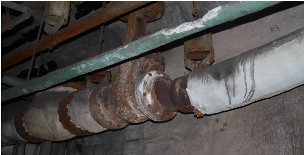
Figuur 5. Leidingbreuk bij een flensverbinding tijdens een aardbeving (Foto: A.M. Cruz)
