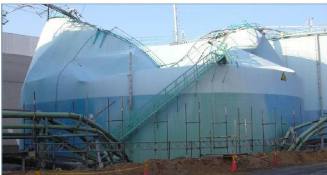
Abb. 1 und 2: Der geborstene Tank und die unterirdische Rohrleitung (Quelle: Bericht der schwedischen Unfalluntersuchungsbehörde).
