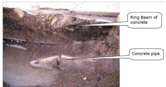
Abb. 1 und 2: Der geborstene Tank und die unterirdische Rohrleitung (Quelle: Bericht der schwedischen Unfalluntersuchungsbehörde).
