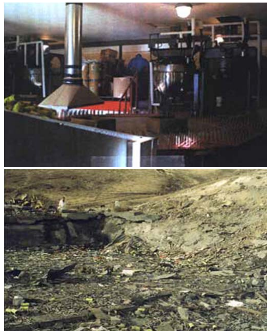
Figuren 2 en 3: 'Booster Room' 2 voor en na de explosie (bron: Chemical Safety Board)
