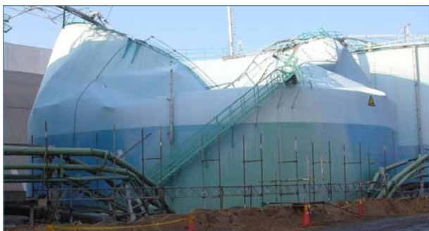
Afbeeldingen 1 en 2: De beschadigde tank en ondergrondse pijpleiding (bron: rapport van de Zweedse Onderzoeksraad)
