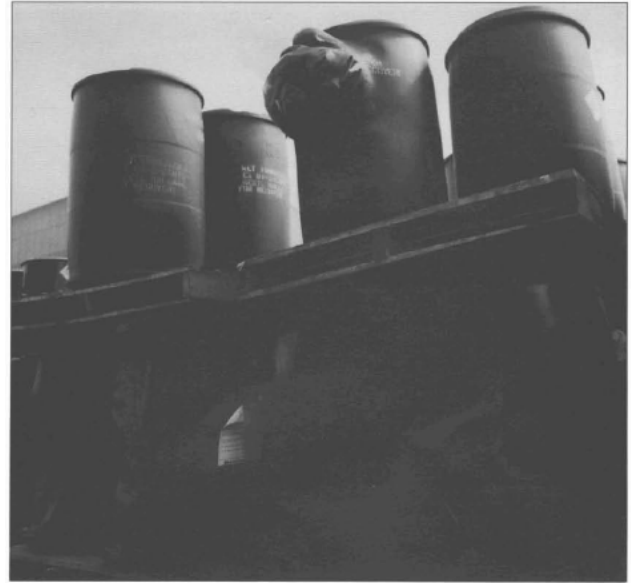
Figuur 3: Plastic vaten in de brandbestendige opslag voor brandbare vloeistoffen die hiteschade en effecten van overdruk vertonen. (HSE, 1992)
