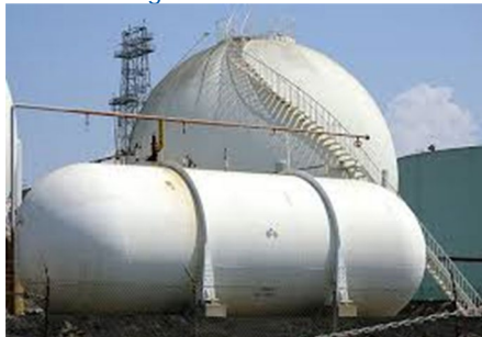
Fig. 1 Butaantanks, een bullet- en bolreservoir Dit bestand is gelicenseerd onder de Creative Commons-Attribution-NonCommercial-NoDerivatives 4.0 International licentie. https://creativecommons.org/licenses/by-nc-nd/4.0/
