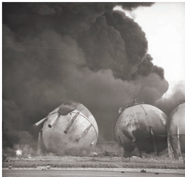
Burnt out storage spheres, Feyzin. Courtesy of Collection Bibliothèque municipale de Lyon, Fonds Georges Vermard, P0702 B02 07 618 00001
