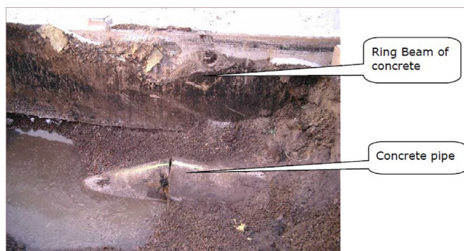
ნახ. 1 და 2: დაზიანებული რეზერვუარი და მიწისქვეშა მილსადენი (წყარო: შვედეთის საგამომიებო საბჭოს მოხსენება).
