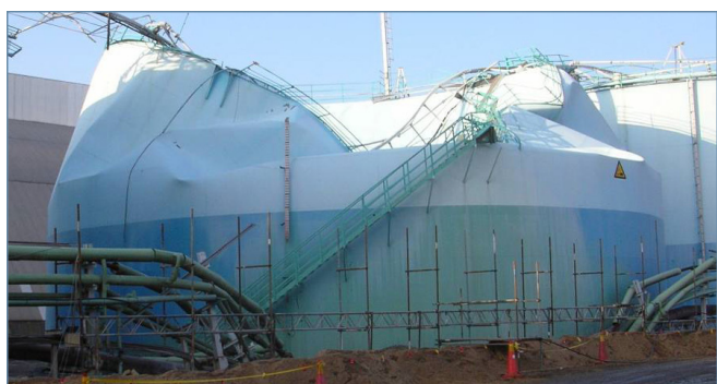
ნახ. 1 და 2: დაზიანებული რეზერვუარი და მიწისქვეშა მილსადენი (წყარო: შვედეთის საგამომიებო საბჭოს მოხსენება).
