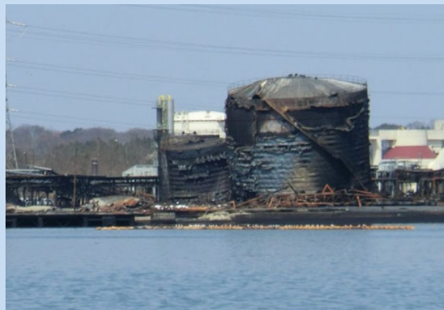
ნახ. 5: დამწვარი ცისტერნები სენდაის ნავთობგადამამუშავებელ ქარხანაში (ფოტო: ს. სქაუთორნი)
