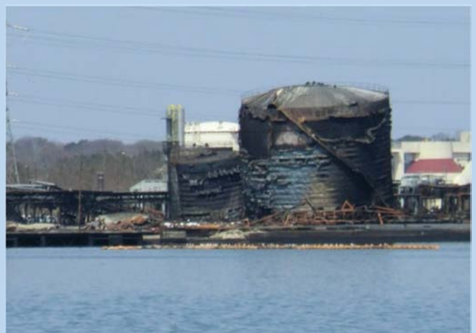
Figura 5: Rezervoarele arse de la rafinăria Sendai, în urma valului tsunami (fotograf: C. Scawthorn)
