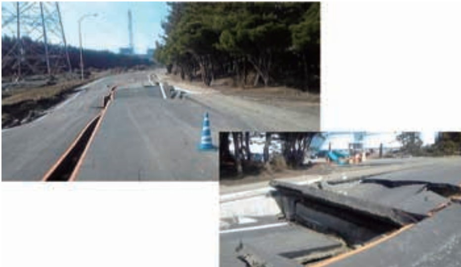
図4 製油所進入道路の様子
