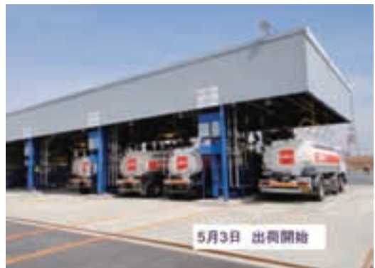
図7 東地区仮設ローリー積場
