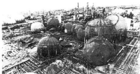
鎮火後の貯槽設備
